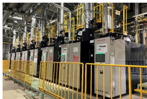
LNG Boiler Facilities (Nickel Refinery)
