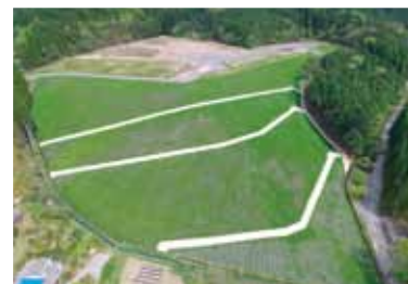
大口第1鉱さい堆積場の安定化工事（左）と工事後の緑化状況（上）
