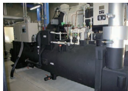
冷水を作る冷凍機
