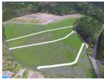
大口第1鉱さい堆積場の安定化工事(右)と工事後の緑化状況(左)
